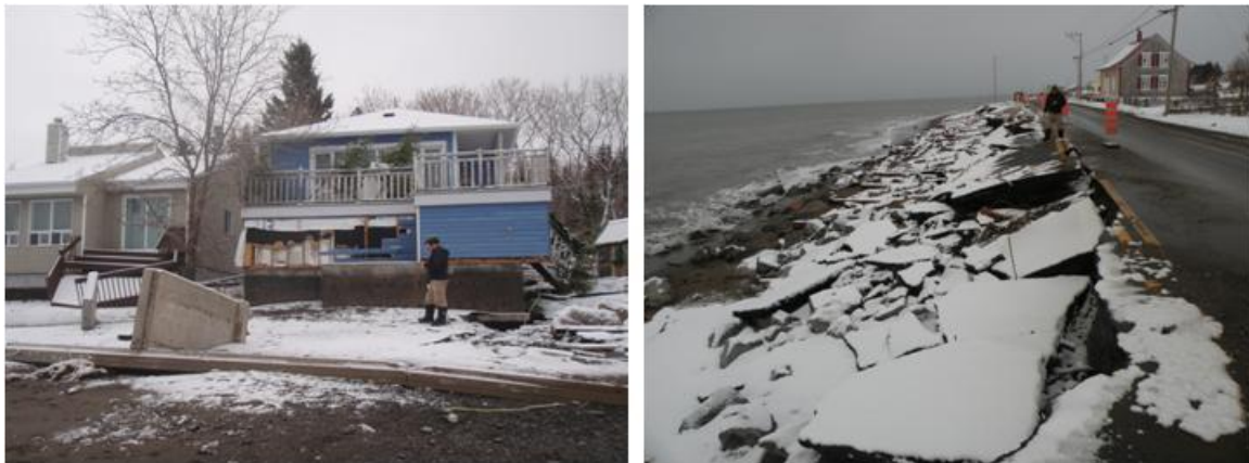
FIGURE 16. RELEVÉ SUR LE TERRAIN AFIN DE DOCUMENTER LES DOMMAGES SUR LE CADRE BÂTI OCCASIONNÉS PAR LA TEMPÊTE DU 6 DÉCEMBRE 2010.
