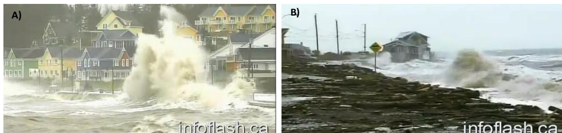
FIGURE 23. INFLUENCE DES STRUCTURES DE PROTECTION SUR L'AGITATION MARINE. VAGUE DE FORTE ÉNERGIE DEVANT MURET (A) ET DEVANT UN ENROCHEMENT (B).
