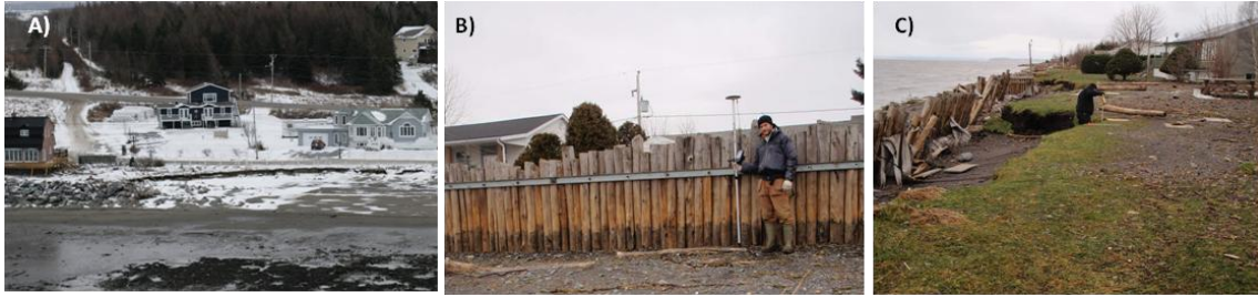
FIGURE 22. L'ALÉA ÉROSION SUITE AU PASSAGE DE LA TEMPÊTE DU 6 DÉCEMBRE 2010 SUR LES CÔTES ARTIFICIELLES. EFFET DE BOUT (A), ABAISSEMENT DE PLAGE (B) ET FORMATION D'UNE MICROFALAISE ACTIVE (C).
