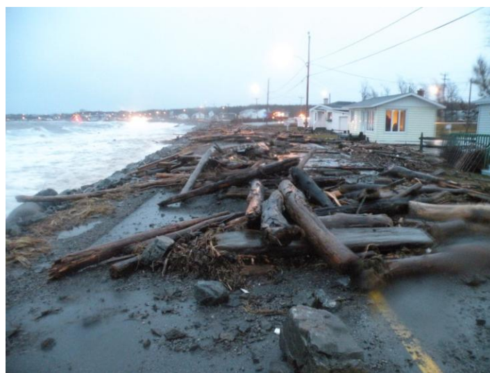
FIGURE 18. SECTEUR DE DÉFERLEMENT SÉVÈRE IDENTIFIÉ PAR LA PRÉSENCE DE GROS DÉBRIS LAISSÉS PAR LES VAGUES LORS DE LA TEMPÊTE DU 6 DÉCEMBRE 2010.
