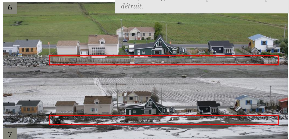
Sainte-Flavie le 15 septembre (photo 6) et le 9 décembre 2010 (Photo 7). Le mur de protection est complètement détruit.
