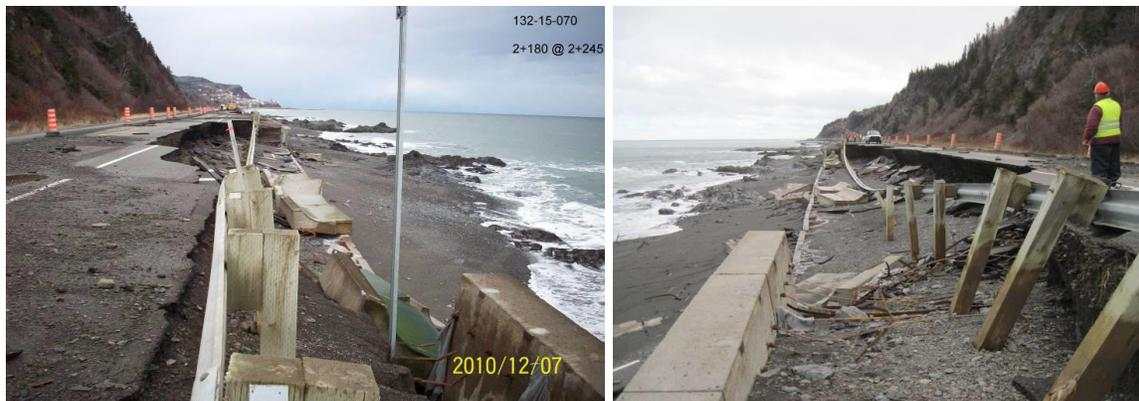
Figure 11. Suite à la tempête du 6 décembre 2010 en Haute-Gaspésie, murs de béton et route 132 partiellement détruits (Source des photos : MTQ)
