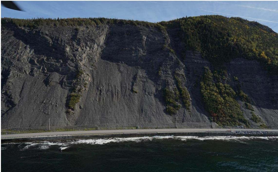
*Figure 25. Route 132 située sur un remblai en pied d'une haute falaise rocheuse*
