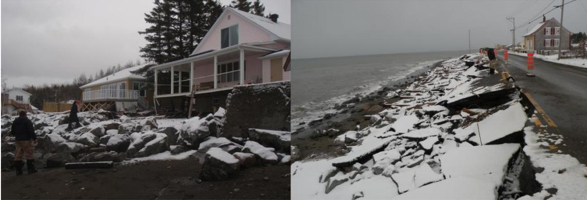
Figure 6. Érosion derrière des ouvrages de protections côtière lors de la tempête du 6 décembre 2010
