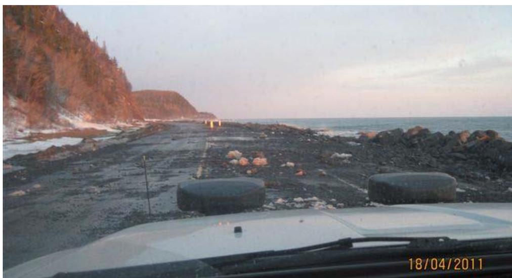
Figure 35. Projection de roches sur la chaussée de la 132 entre Marsoui et Rivière-à-Claude (© MTQ)
