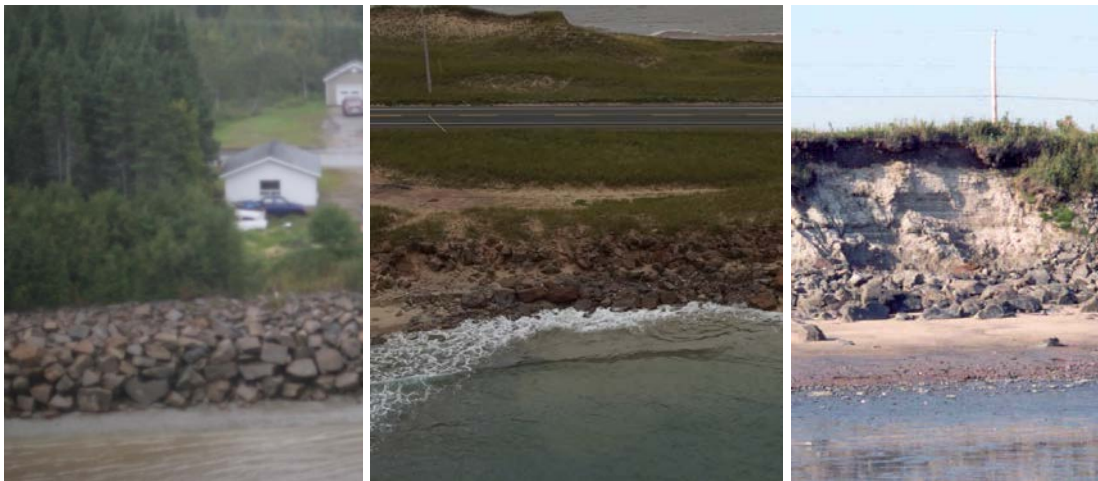
Figure 20. Gauche : Ouvrage en bon état ; centre : Ouvrage très endommagé ; et droite : ouvrage complètement endommagé
