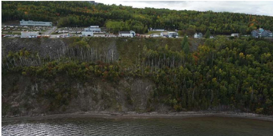
Figure 14. Côte à falaise rocheuse avec du remblai en sommet de talus (Gaspé)
