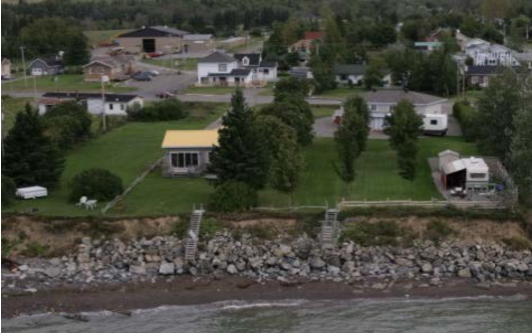
Figure 19. Côte semi-végétalisée malgré la présence d'un enrochement (Carleton-sur-Mer, sept. 2010)
