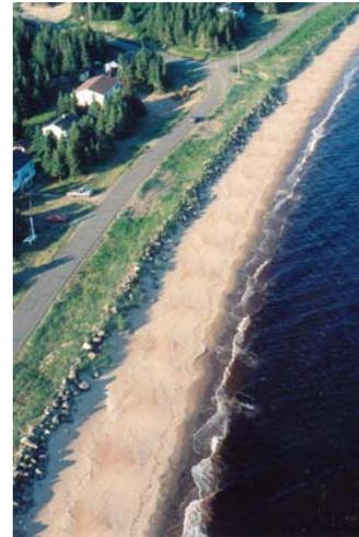
Photo 1. Enrochement pour protéger la route dans la portion ouest du village
