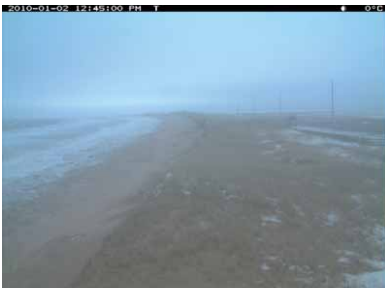
B) Formation d'une rampe de sable par les processus éoliens et ensablement de l'escalier (photo 2 janvier 2010)
