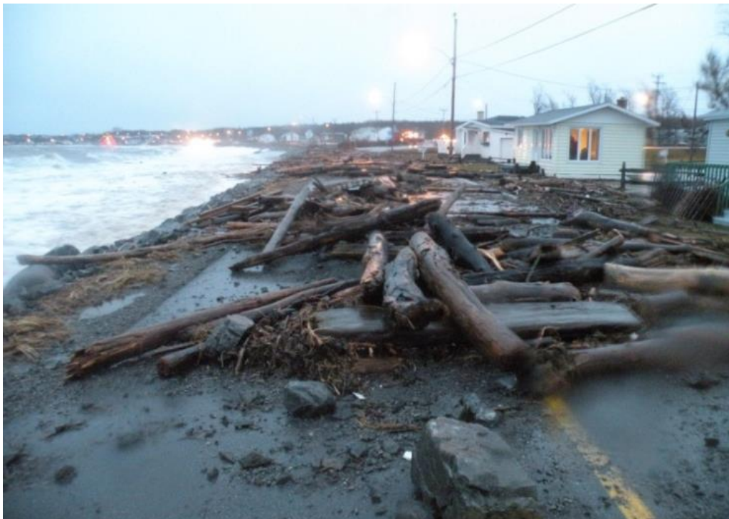
Figure 16. Débris de bois et blocs d'enrochement sur une route suite à la tempête du 6 décembre 2010 à Rimouski (© LDGIZC-UQAR)
