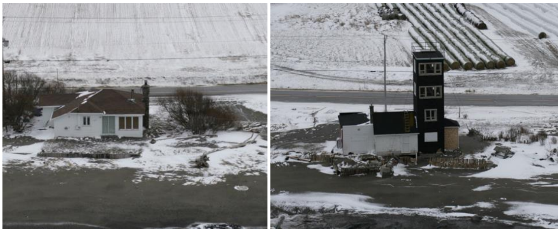
Figure 25. Images héliportées post-tempête de bâtiments dans le secteur M-56 (9 décembre 2010) (© LDGIZC-UQAR)
